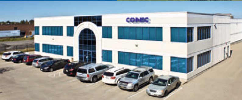
CONEC Canada, Brampton
