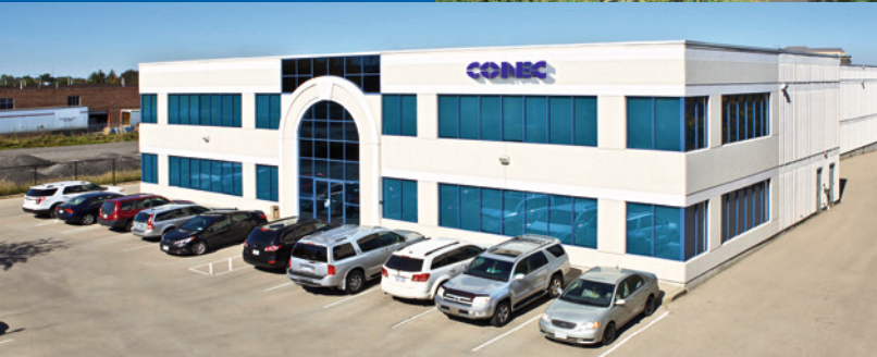
CONEC Canada, Brampton
